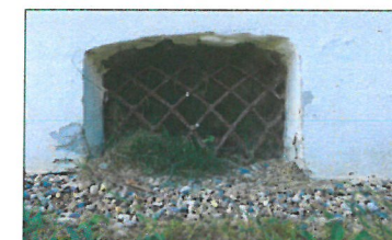
Lüftungsfenster zur Familiengruft
